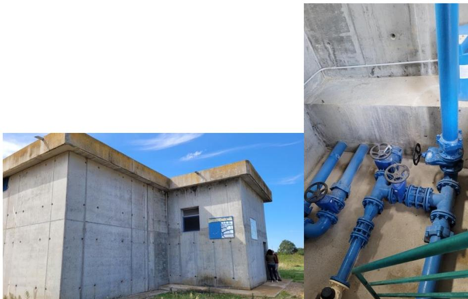
Figura 17. Depósito de 770 m<sup>3</sup> y cámara de válvulas
