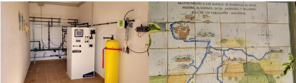
Figura 11. ETAP de Ejea. Desinfección y esquema de distribución
