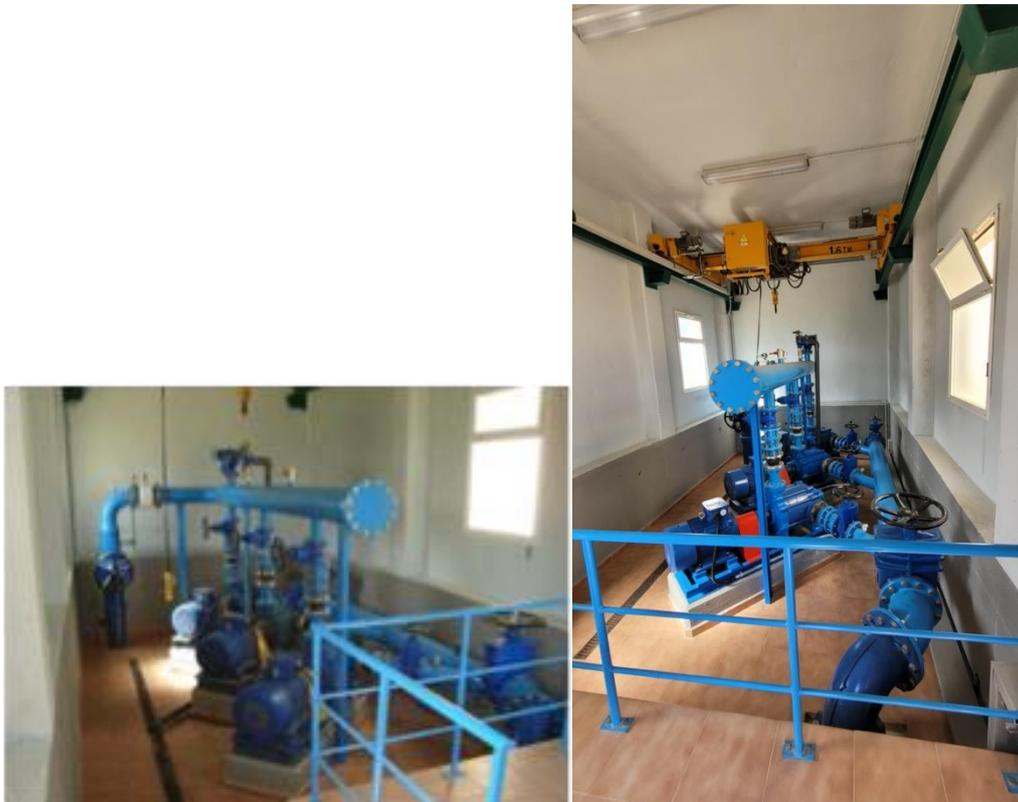
Figura 13. Estación de bombeo al depósito de 1.000 m<sup>3</sup>
